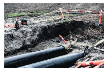
De store rør glider stille og roligt gennem borehullet. Foto: Mette Hørch
